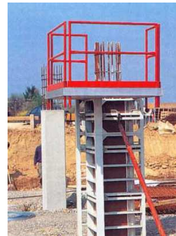
L'elevazione di murature e di pilastri in c.a. devono realizzate con postazioni munite di parapetto normale
