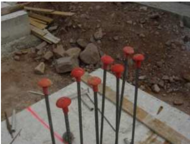
Le armature della platea devono essere protette con "funghi"
